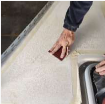
Carteggiatura della superficie, applicazione di una mano di GrypsCover R-ELASTIC e successiva realizzazione della finitura antisdrucciolo con GrypsCover R-ELASTIC additivato con Additivo ANTISCIVOLO 01-03
