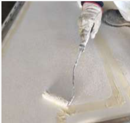
Carteggiatura della superficie, applicazione di una mano di GrypsCover R-ELASTIC e successiva realizzazione della finitura antisdrucciolo con GrypsCover R-ELASTIC additivato con Additivo ANTISCIVOLO 01-03
