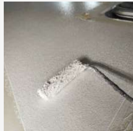
Carteggiatura della superficie, applicazione di una mano di GrypsCover R-ELASTIC e successiva realizzazione della finitura antisdrucciolo con GrypsCover R-ELASTIC additivato con Additivo ANTISCIVOLO 01-03
